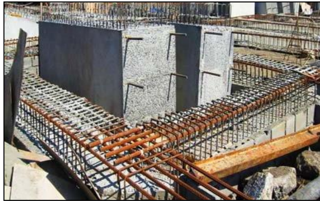
Gambar 4.12 Stuktur Beton Bertulang sumber : http://www.teknik-sipil.com
