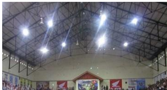
Gambar 2.5 Struktur rangka ruang atap (Sumber : Dokumentasi pribadi, 2020)
