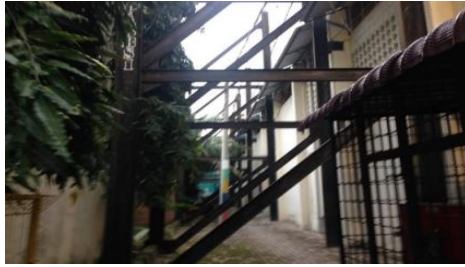
Gambar 2.3 Baja Penyokong Gedung Olahraga (Sumber : Dokumentasi pribadi)
