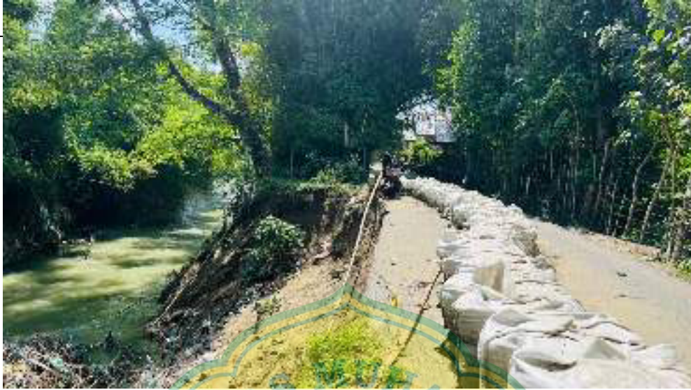
Gambar A.1.7 = Foto Yang Diambil Langsung Pada Lokasi Yang Akan Menjadi Topik Penelitian Sumber = Dokumentasi Lapangan
