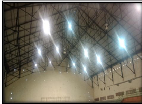
Gambar 2.13. Struktur rangka ruang atap (Sumber : Dokumentasi pribadi, 2020)
