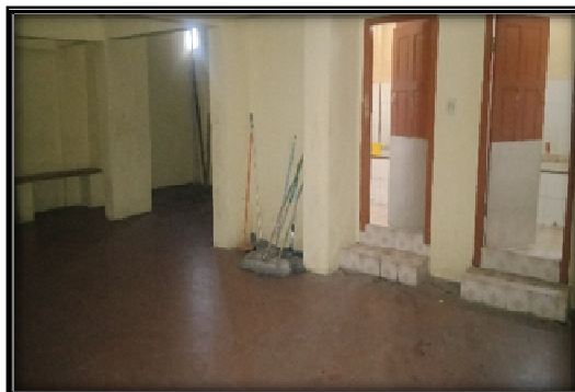
Gambar 2.18. Kamar Mandi GOR KONI ACEH (Sumber : Dokumentasi pribadi, 2020)
