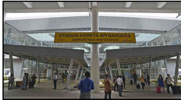
Gambar 2.16 Stasiun Kereta Api Bandara Kualanamu Sumber : Dokumen Pribadi, 2018
