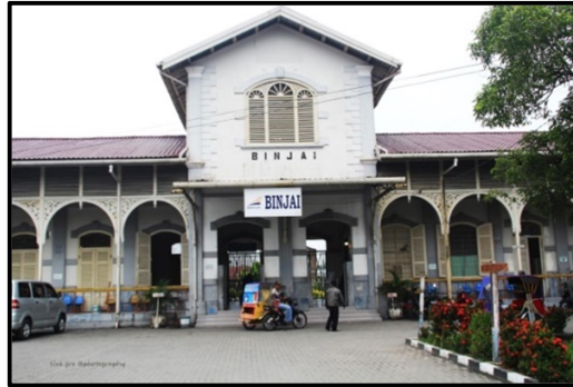
Gambar 2.12 Stasiun Kereta Api Binjai Sumber : Dokumen Pribadi, 2018
