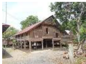
Penerapan lantai pilotis atau panggung yang merupakan adopsi Rumah Aceh
