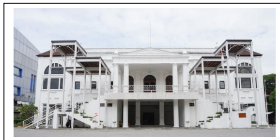
Gambar 2.24. Tampak Bangunan Taman Budaya (Sumber : Dokumentasi, 2023)
