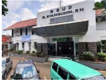
Gambar 2.17. Fasad Bangunan Rumah Sakit UD R. Syamsudin, SH Sumber: ditmutunakes.kemkes.go.id,2024
