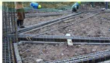
Gambar 4.14 Struktur Sloof dengan besi Ulir
