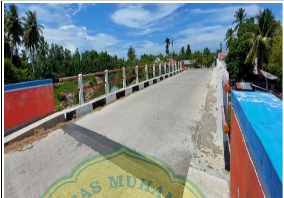
Gambar 4.5 Jembatan Teupin Peraho
