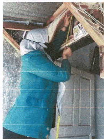
Pengukuran luas ventilasi
