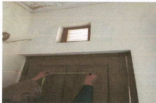
Pengukuran luas ventilasi
