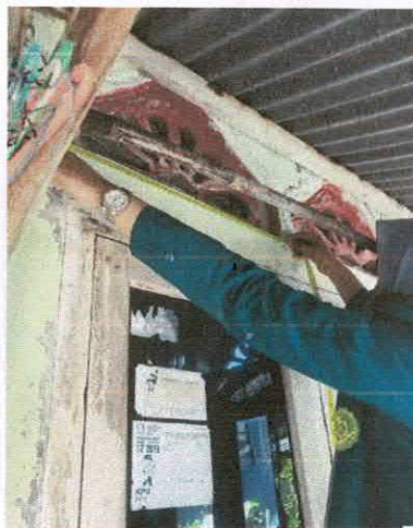
Pengukuran luas ventilasi
