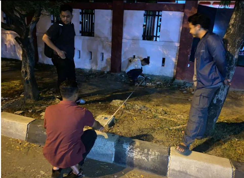
Gambar A.3.13 : Pengukuran Geometrik Jalan Cut Nyak Dhien Hari/Tanggal : Jumat, 20 Juni 2025
