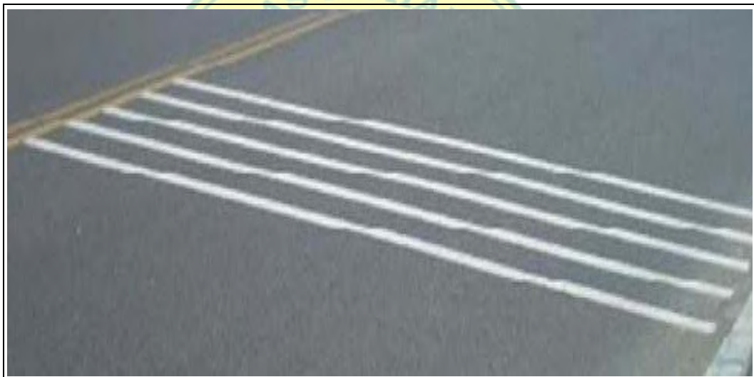
Gambar 2.4 : Pita penggaduh ( rumble strips )
