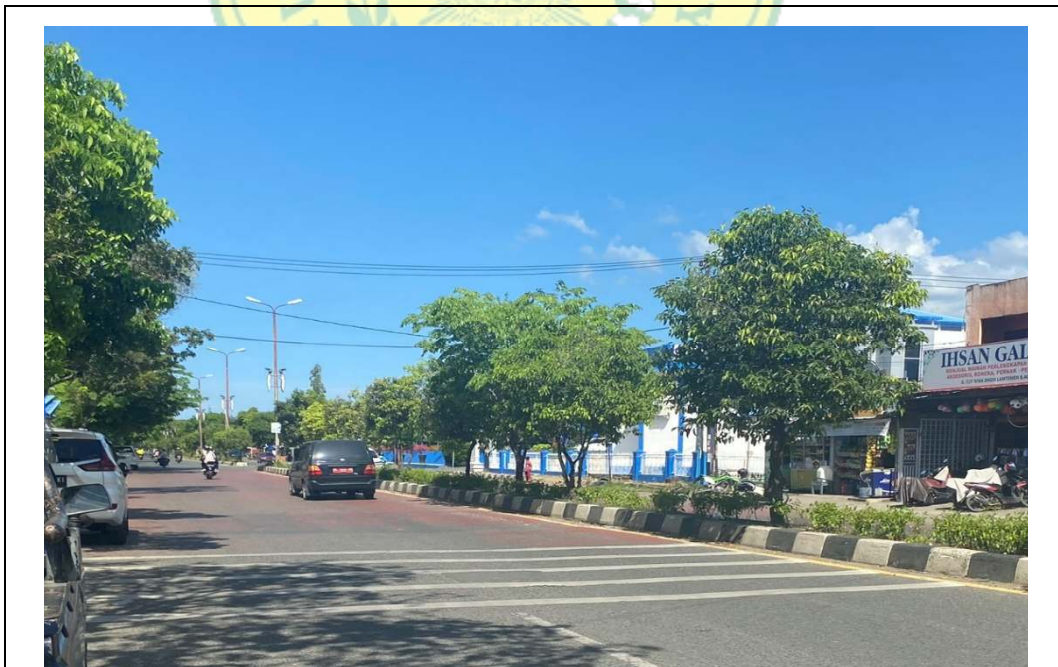
Gambar A.3.12 : Pita Penggaduh ( Rumble Strips ) Hari/Tanggal : Selasa, 07 Januari 2025
