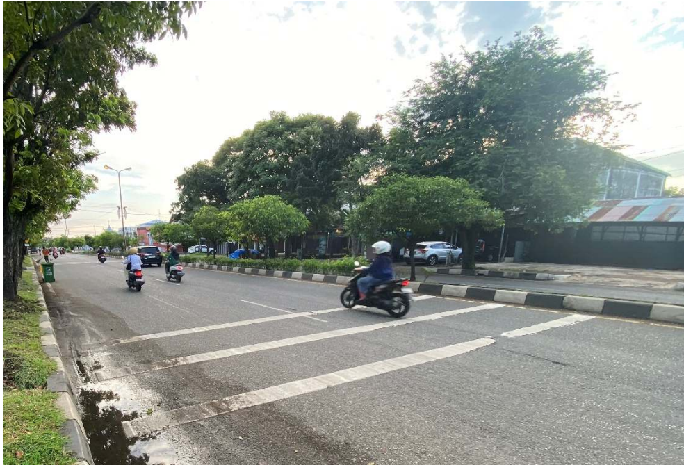
Gambar A.3.9 : Pita Penggaduh ( Rumble Strips ) RS 2 Hari/Tanggal : Kamis, 02 Januari 2025
