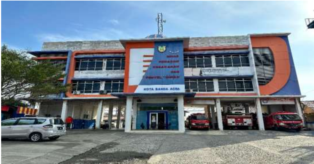
Gambar 5.1 Dinas Pemadam Kebakaran dan Penyelamat (DPKP) Kota Banda Aceh
